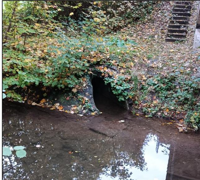
Die Einleitstelle des Regenwasserkanals liegt unter dem Wasserspiegel des Brembachs. Am Tag der Bestandsaufnahme lag der WSP am Anfang des Auslasses bei 182,95 m NN. Das Rohr stand ca. 10 cm unter Wasser. Der Einstau erstreckt sich aber nur auf den direkten Auslaufbereich.
