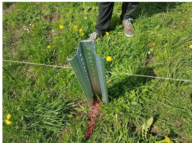
Abbildung 7: Rammfundament
