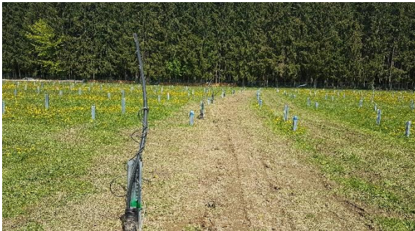
Abbildung 5: Verfüllter Kabelgraben
