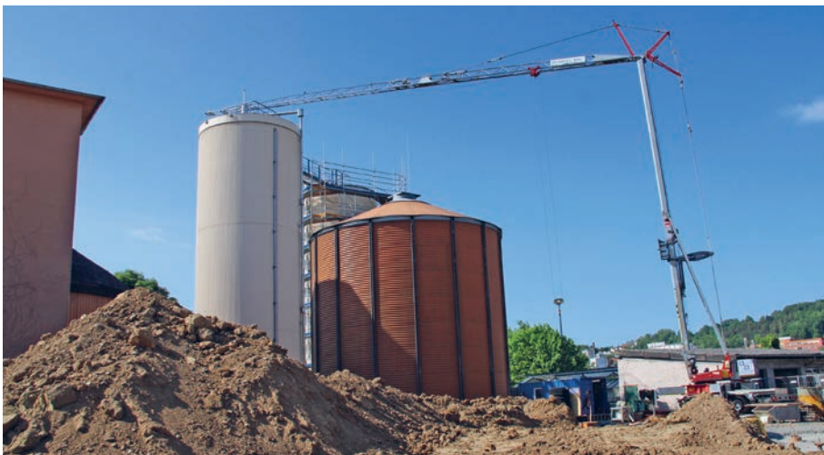
Der Gasbehälter (roter Zylinder) wird durch einen Neubau in Kuppelform ersetzt.
